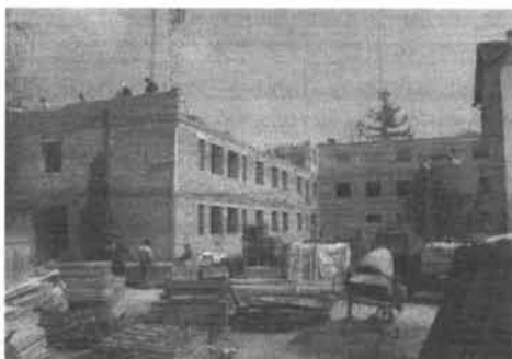
Stavba chem. pavilonu
