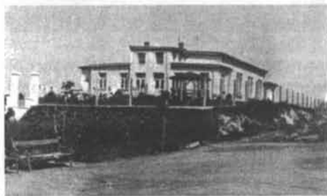
Pavilón sekce fytopatologické
