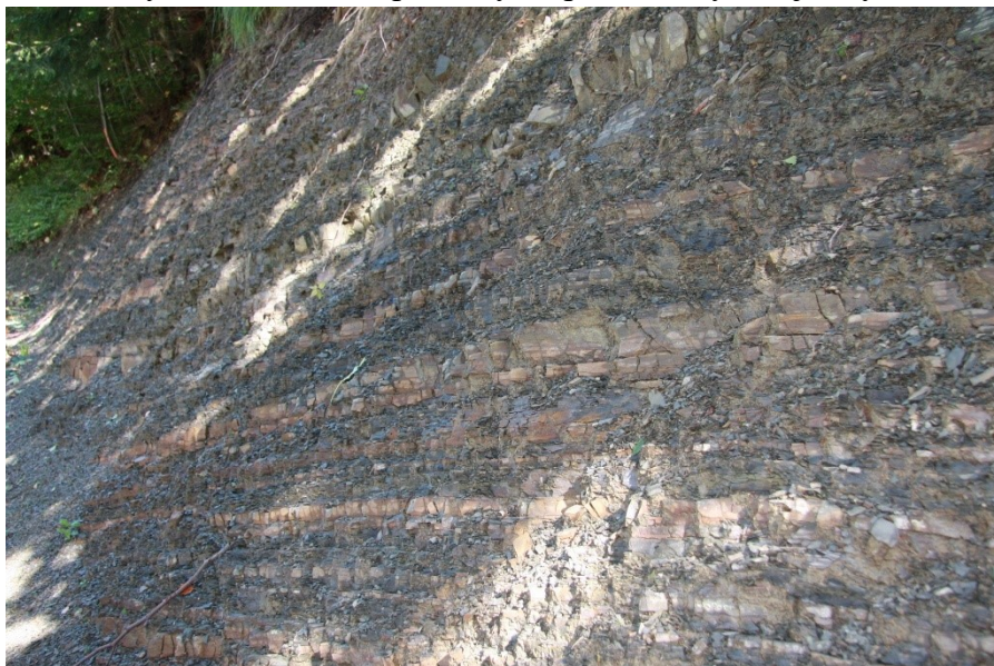
Obr. 2: Flyšové střídání slepencových, pískovcových a jílových složek
